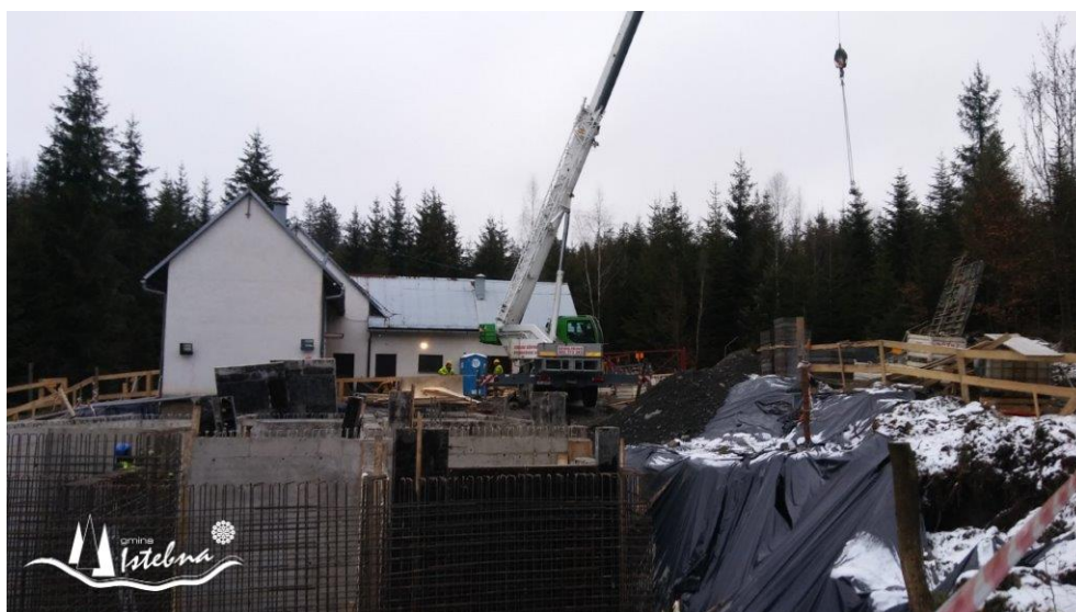
Zdjęcie: Trwające prace w ramach przebudowy oczyszczalni ścieków Pustki w Koniakowie.
