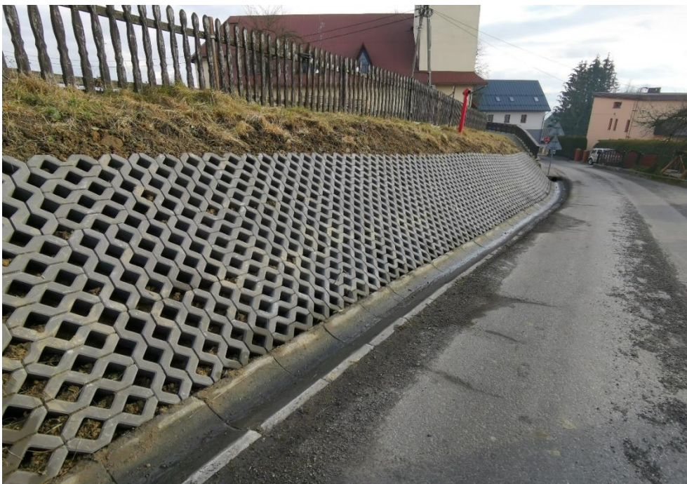
Zdjęcie: Umocnienie skarpy przy drodze gminnej Łupienie, Jaworzynka Trzyciatek.
