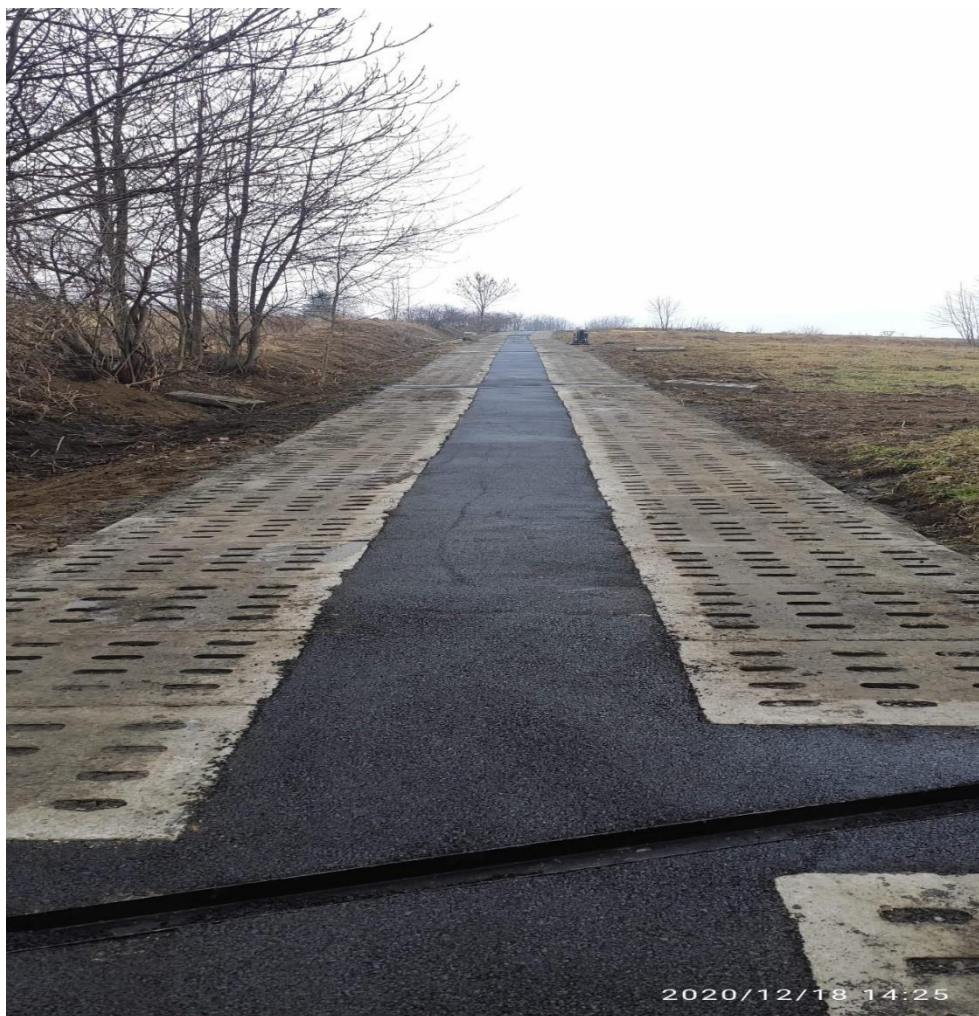
Zdjęcie: Remont drogi gminnej nr 617 070 S od Juroszka we wsi Istebna.
