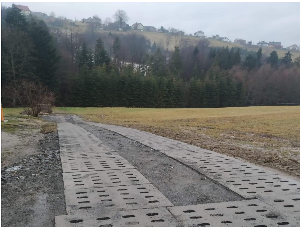
Zdjęcie: Remont drogi gminnej Deje w Koniakowie.
