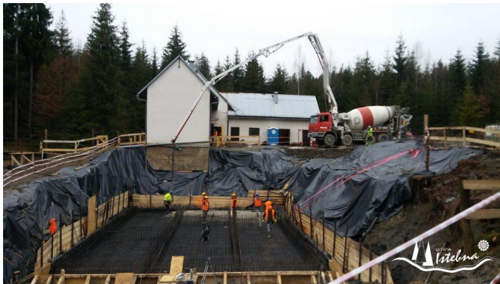
Zdjęcie: Przebudowa z rozbudową oczyszczalni ścieków Pustki w Koniakowie.
