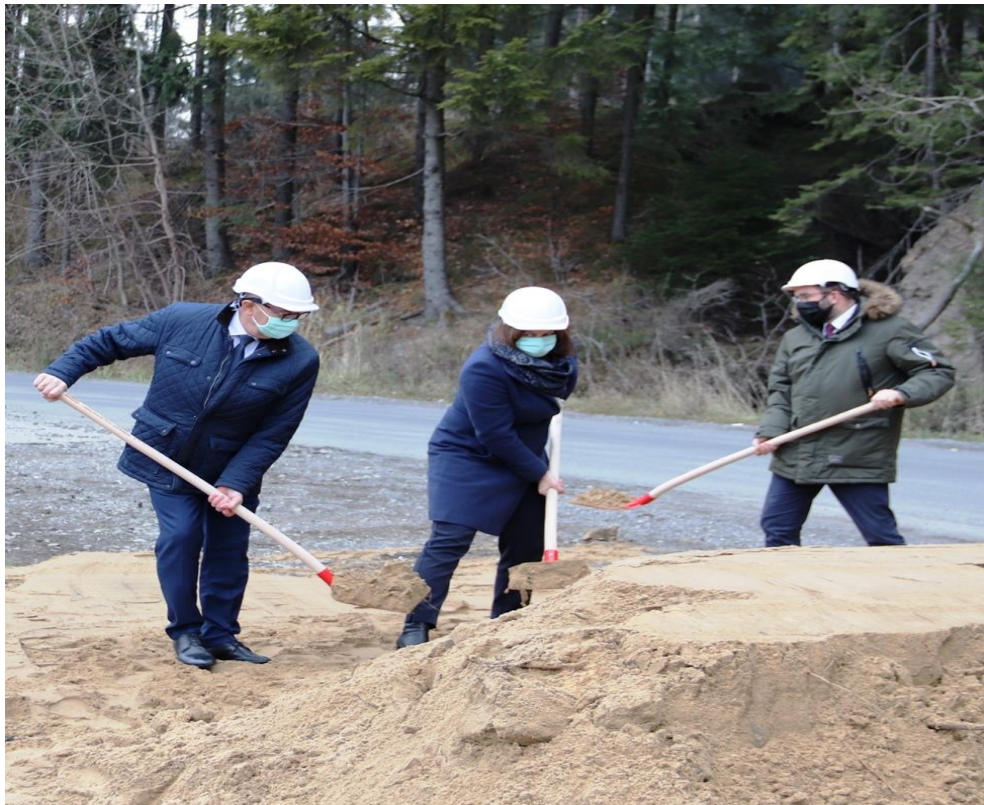
Zdjęcie: Wbicie pierwszej łopaty na rozbudowywanej drodze Zaolzie-etap II.
