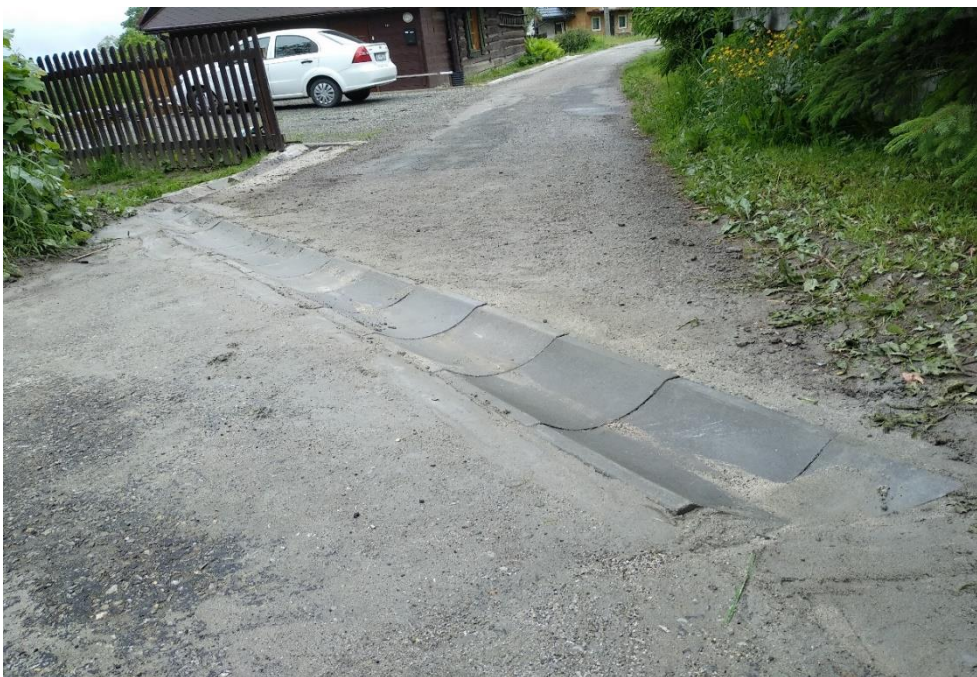
Zdjęcie: Remont odwodnienia Szarce, sołectwo Istebna.
