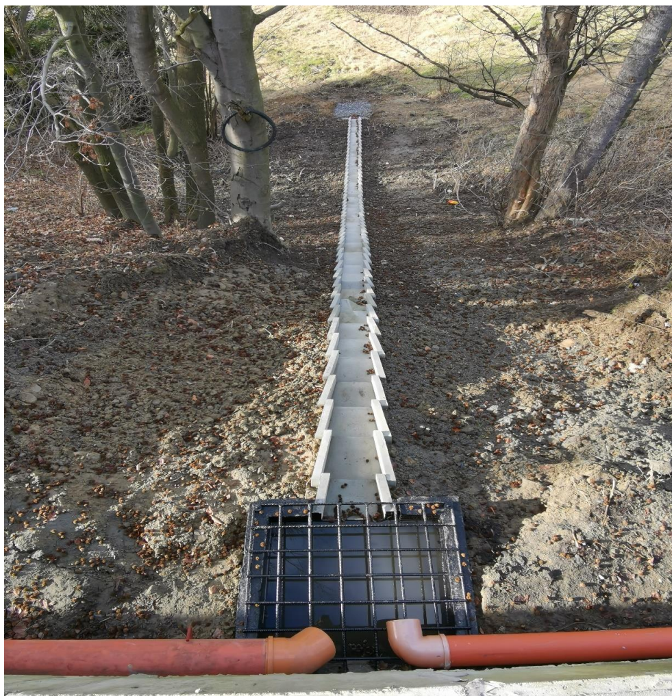
Zdjęcie: Wykonanie odwodnienia drogi gminnej Legiery we wsi Koniaków.
