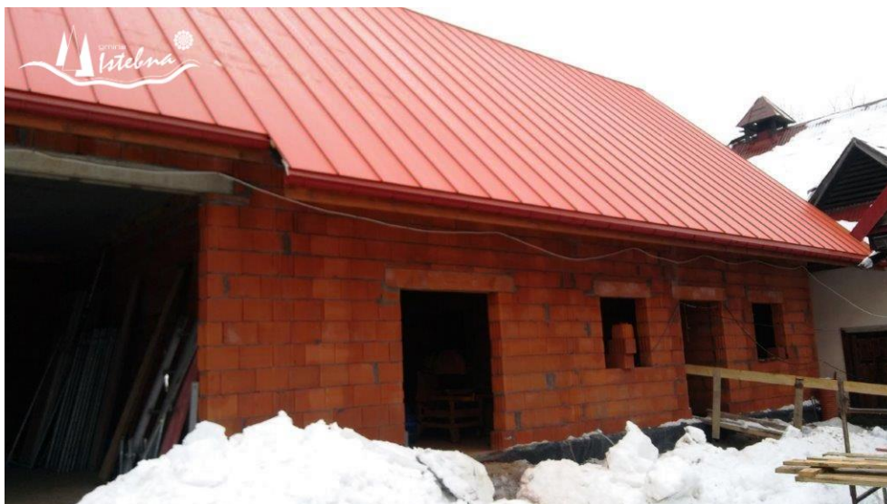
Zdjęcie: Trwające prace w ramach przebudowy oczyszczalni ścieków Gliniane w Istebnej.
