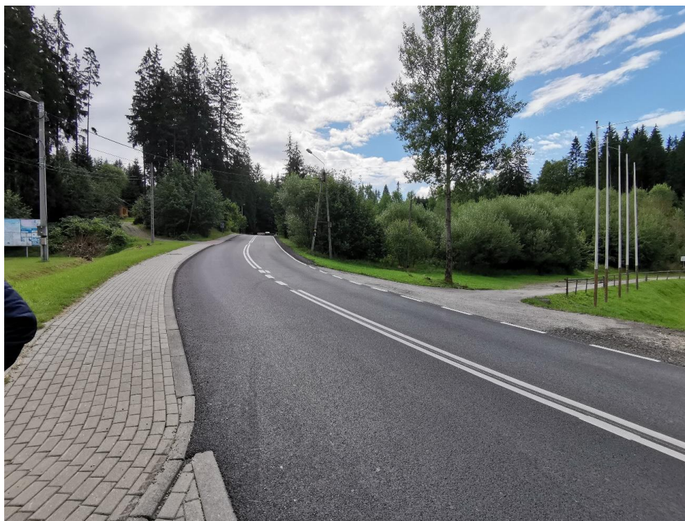
Zdjęcie: Nowa nakładka bitumiczna na drodze DW 941
