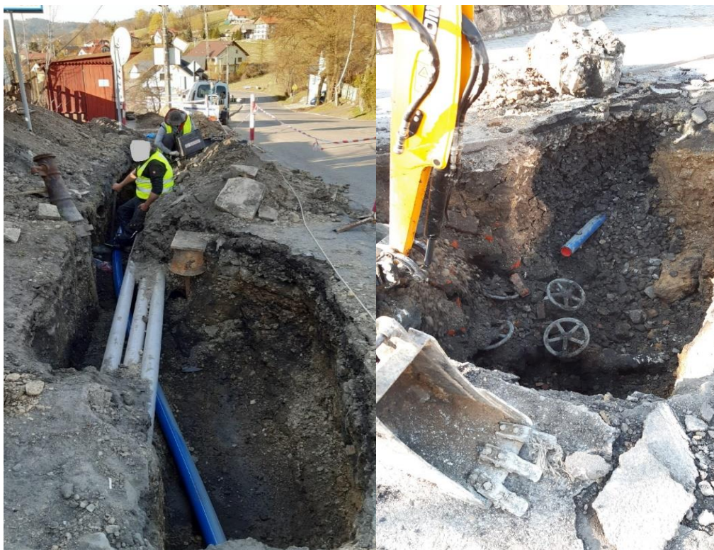
Zdjęcia: Prace nad wymianą awaryjnej sieci wodociągowej Istebna Centrum
