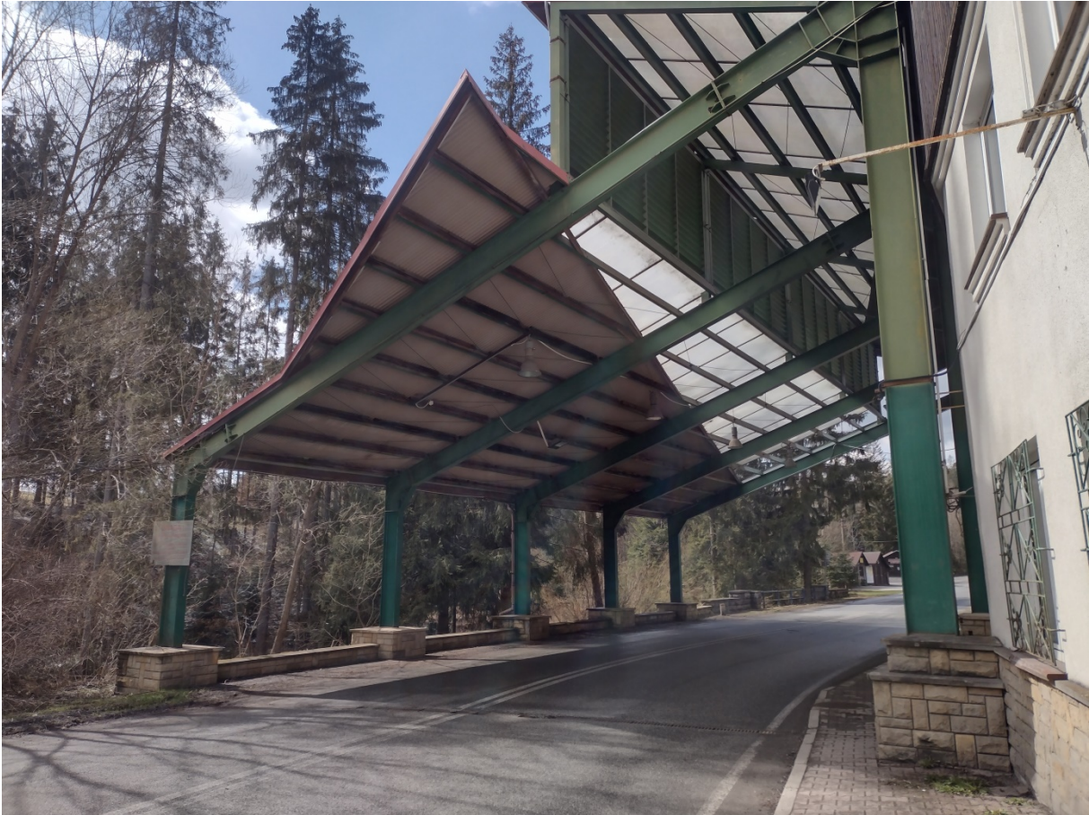
Fot. 2. Zadaszenie stalowe – widok 2.
