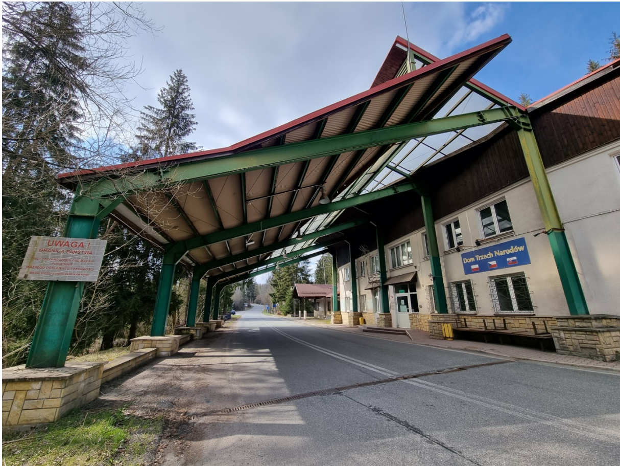
Fot. 1. Zadaszenie stalowe – widok 1.
