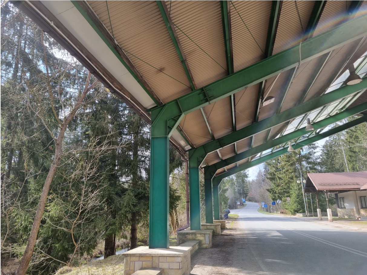
Fot. 3. Zadaszenie stalowe – widok 3.
