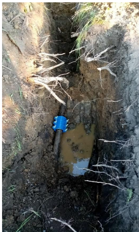
Zdjęcie 4 Opaska zaciskowa DN100 na wodociągu Koniaków Gronik.
