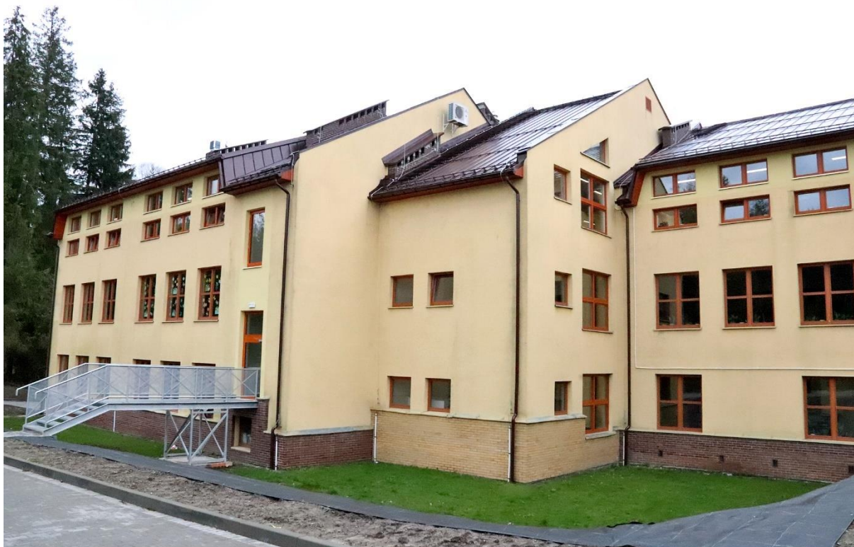
Zdjęcie 45 Segmenty A i B budynku po realizacji prac zewnętrznych.
