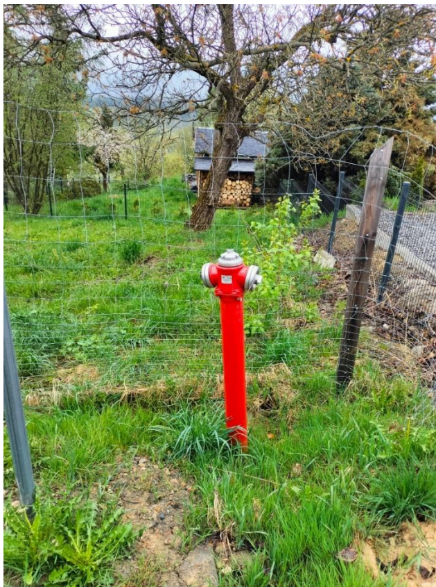
Zdjęcie 2 Nowy hydrant w okolicach Jaworzynki Klimki.
