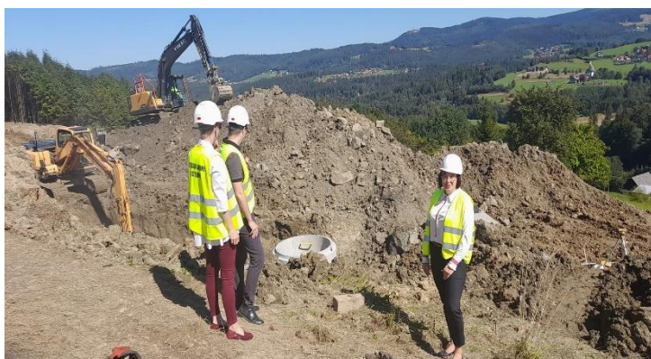
Zdjęcie 22 Kanalizacja Matyska Kadłuby w trakcie prac.
