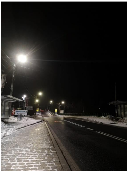
Zdjęcie 10 Oświetlenie nocne drogi Dzielec w technologii LED.
