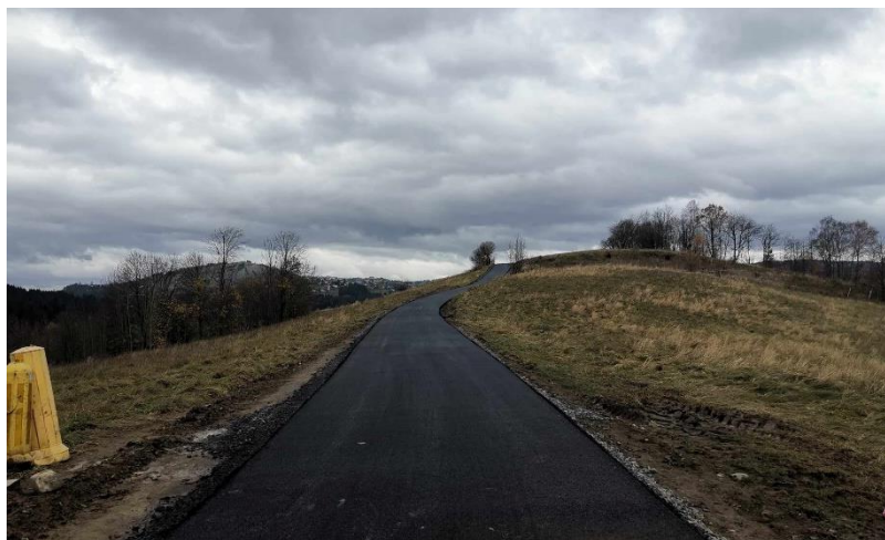
Zdjęcie 28 Droga Groń w Jaworzynce.
