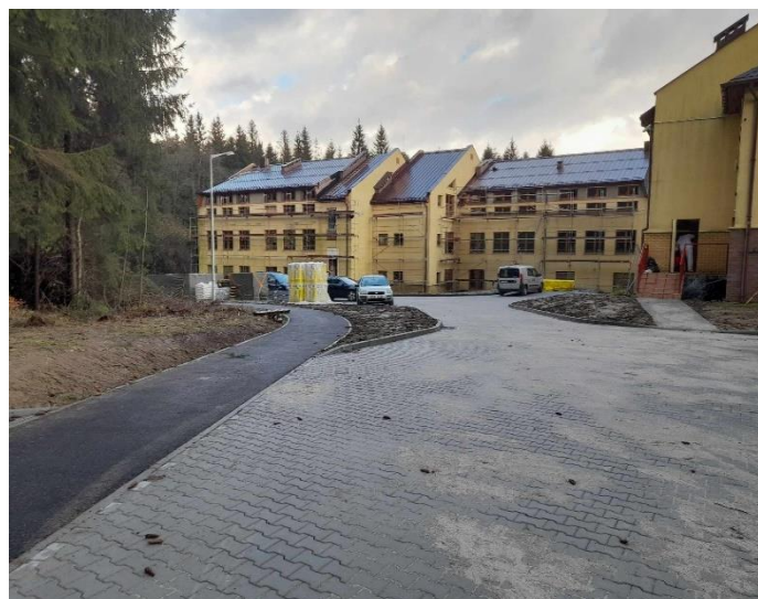
Zdjęcie 44 Segmenty A i B oraz plac manewrowy w trakcie prac.
