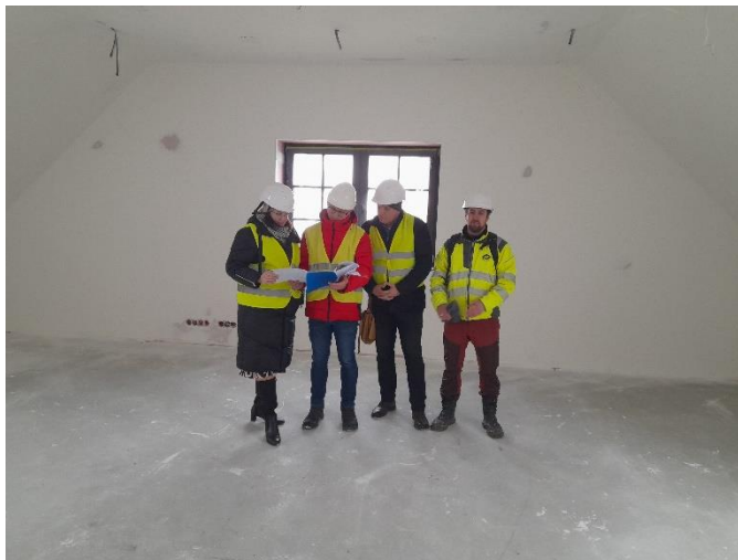
Zdjęcie 41 Poddasze budynku GOK w trakcie prac wykończeniowych.
