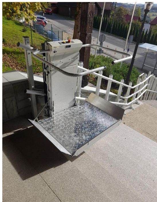
Zdjęcie 46 Platforma przyschodowa umożliwiająca transport osób poruszających się na wózkach inwalidzkich.
