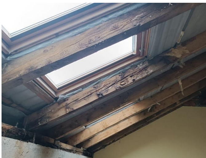
Zdjęcie 43 Stan więźby budynku po odkrywce.
