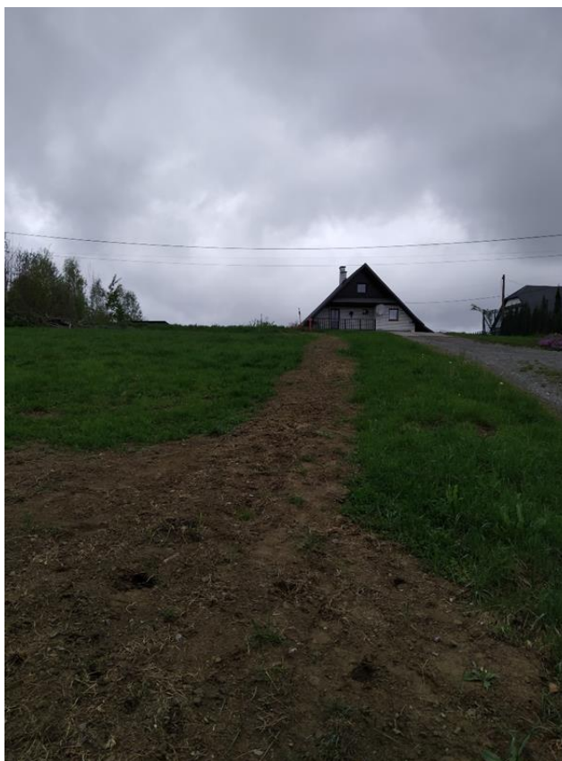
Zdjęcie 1 Wyrównany teren działki po wymianie odcinka sieci wodociągowej w rejonie Istebnej Beskid.
