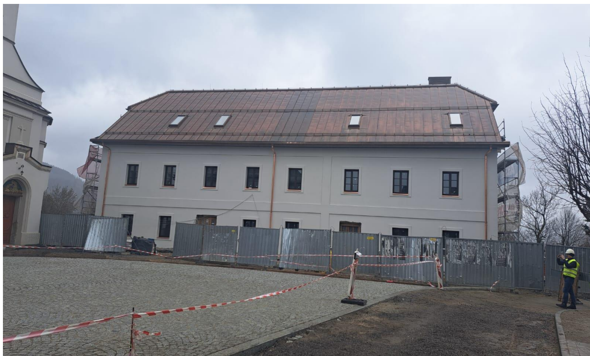
Zdjęcie 40 Budynek GOK w Istebnej po wykonaniu elewacji wraz z rozpoczętą wymianą nawierzchni placu kościelnego.
