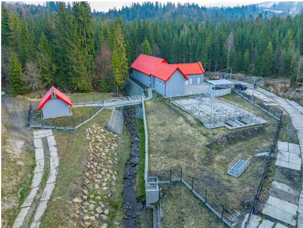
Zdjęcie 24 Oczyszczalnia ścieków Pustki w Koniakowie po rozbudowie wraz z wykonanym ogrodzeniem.
