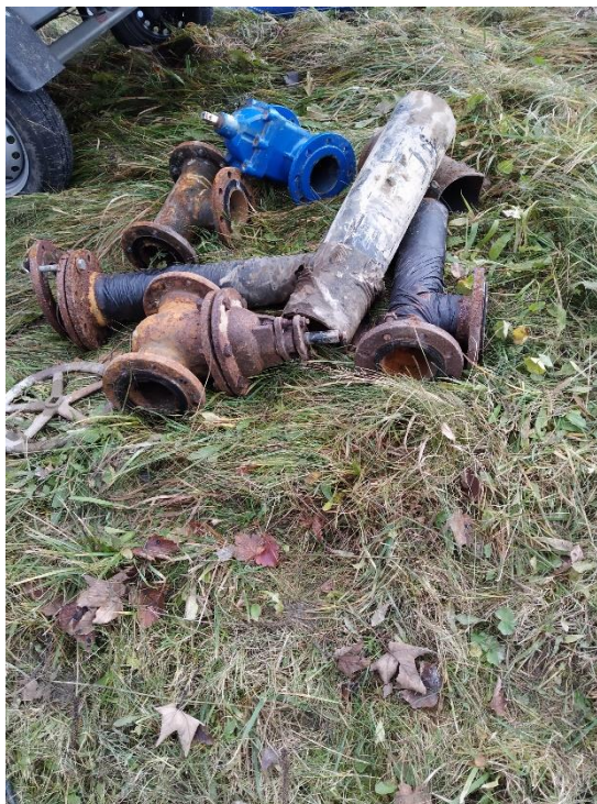
Zdjęcie 8 Studnia wodomierzowa Koniaków Ochodzita – wymontowana stara armatura wodociągowa.
