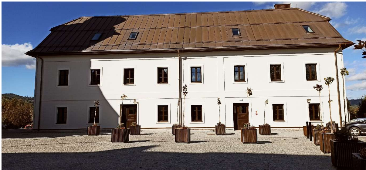
Zdjęcie 34 Wyremontowany Budynek Gminnego Ośrodka Kultury.
