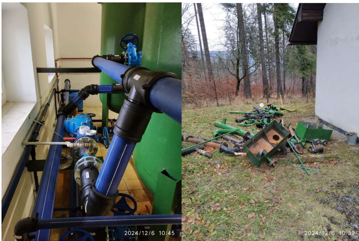
Zdjęcie 5 Z lewej: Wymieniona armatura wodociągowa w SUW Jaworzynka Szkawlonka. Z Prawej: Wycięta stara armatura wodociągowa z SUW Jaworzynka Szkawlonka.
