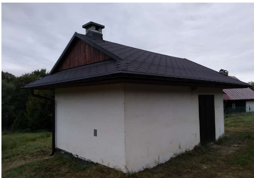
Zdjęcie 6 Budynek przepompowni wody Istebna Szarce po wymianie dachu.
