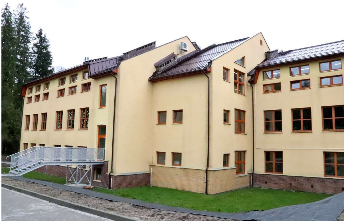
Zdjęcie 35 Segmenty A i B budynku po realizacji prac zewnętrznych.
